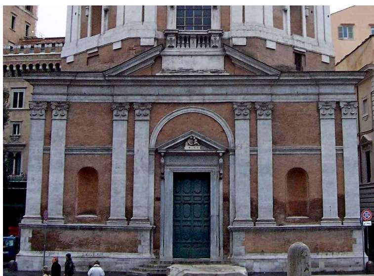
La façade de l'église Santa Maria di Loreto de Rome, par l'architecte Antonio da Sangallo le Jeune (après 1507)
