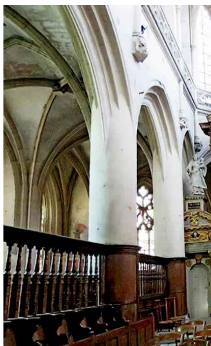
Église Notre-Dame de Carentan, France, piliers de la nef (1440-1470)
