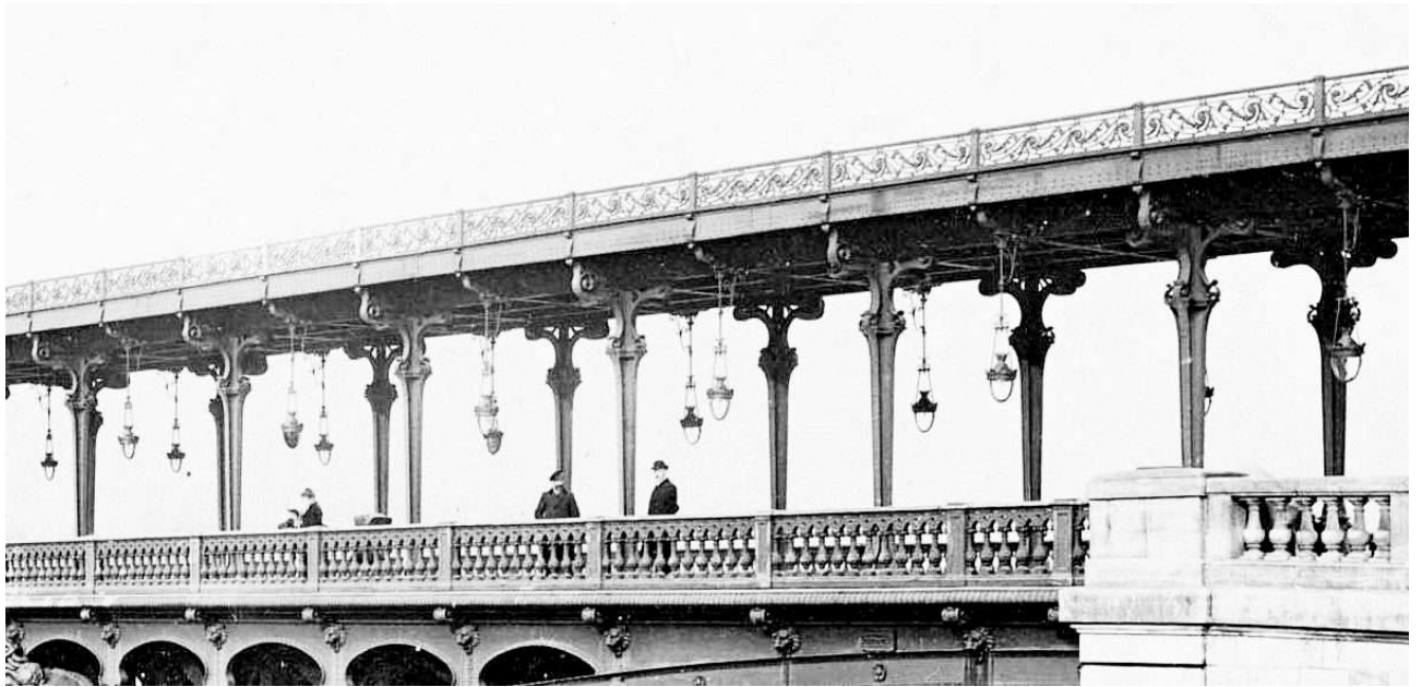
Jean-Camille Formigé : l'étage du pont de Bir-Hakeim soutenant une ligne de métro à Paris, France (1903-1905) - photographies de 1906 Source de l'image : https://fr.wikipedia.org/wiki/Pont_de_Bir-Hakeim
