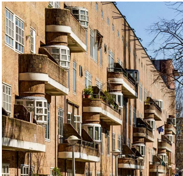
Michel de Klerk : façade d'un immeuble de l'avenue Vrijheidslaan à Amsterdam, Pays-Bas (1921-1923)
