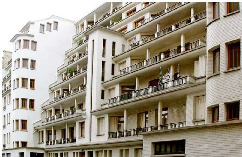
Henri Sauvage avec Charles Sarazin : à gauche, logements sociaux à Paris, France (1930-1934) Ci-dessous, projet pour des immeubles à gradins en front de Seine à Paris (1928)
