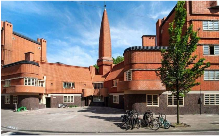
Michel de Klerk : ancien bureau de poste transformé en musée de l'école d'architecture d'Amsterdam dans le quartier Het Schip (Le Navire) d'Amsterdam, Pays-Bas (1919)
