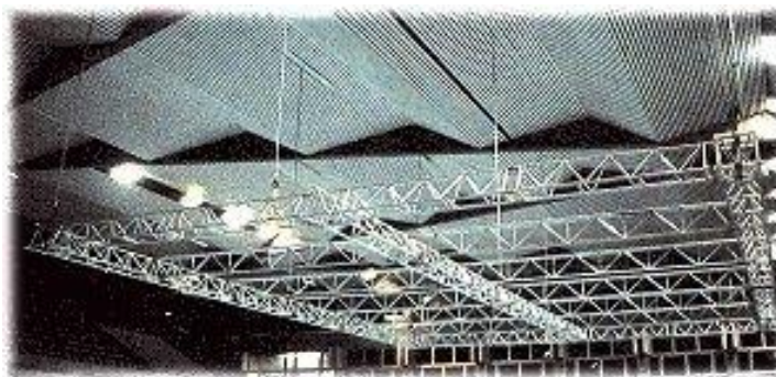
Illustration I-7 Gril temporaire fabriqué avec des trusses (20 Ko)
