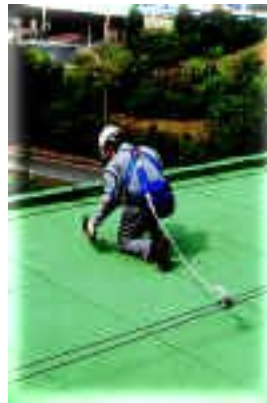
Illustration V-8 Exemple de ligne de vie (5 Ko)
