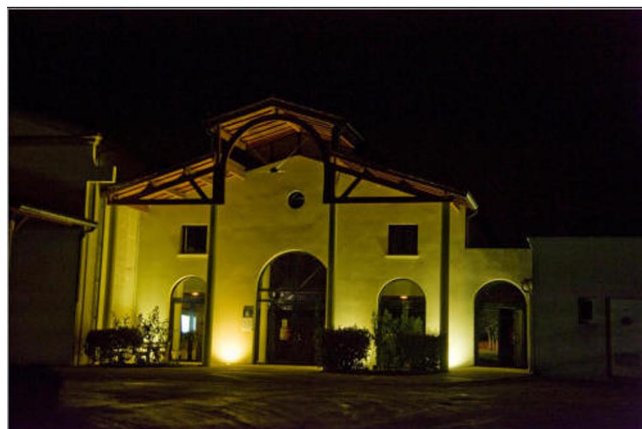
Chai et Salle de réception du Lycée
