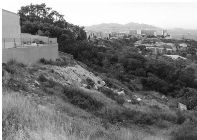
Photo 2. Station de La Viste, dont la moitié environ a été endommagée par la construction d'un lotissement.
