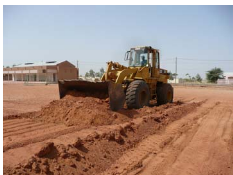
Nivellement du terrain de sport
