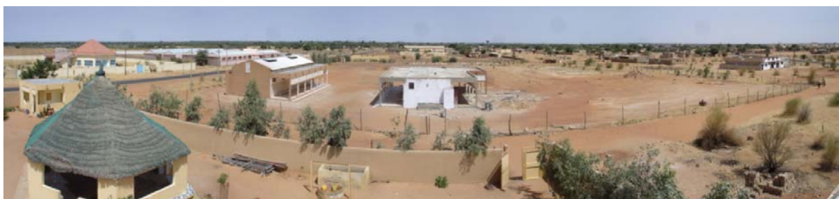
Les deux premiers modules du groupe scolaire vus du toit du centre Morgane
