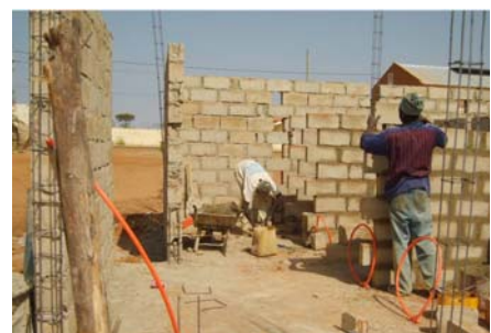
Les premiers murs le 15 mars 2008
