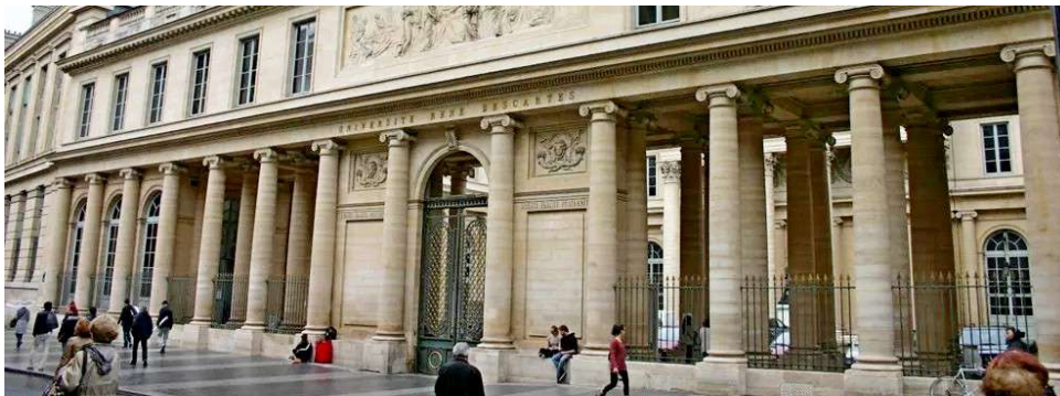
Jacques Gondouin : façade de l'ancienne École de Chirurgie à Paris, France (1769-1775)
