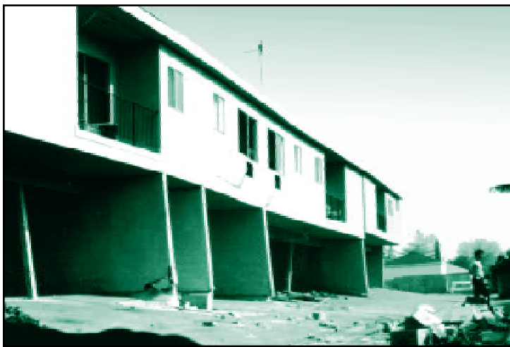
Défaillance d'un premier étage trop faible lors du tremblement de terre de San Fernando (Californie) en 1971.
