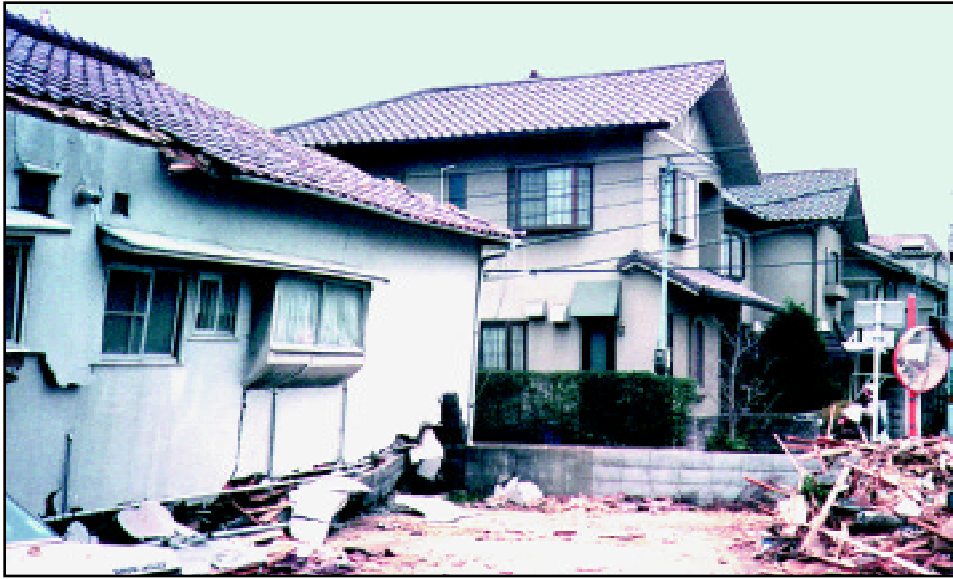
Effets du tremblement de terre de Kobe (Japon) en 1995 : trois maisons à ossature bois de style canadien non endommagées (à l'arrière-plan), et une maison plus ancienne détruite (à l'avant-plan).
