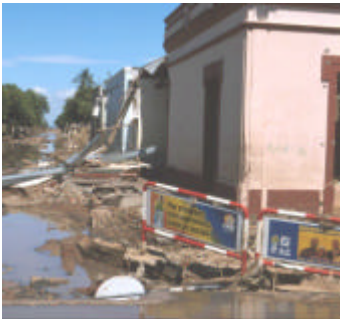
Inondations à Maputo, Mozambique. Photo: Clive Shirley
